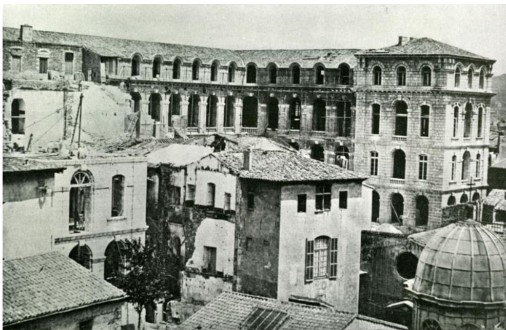
Destruction de l'ancien hôpital et achèvement des deux ailes en retour
