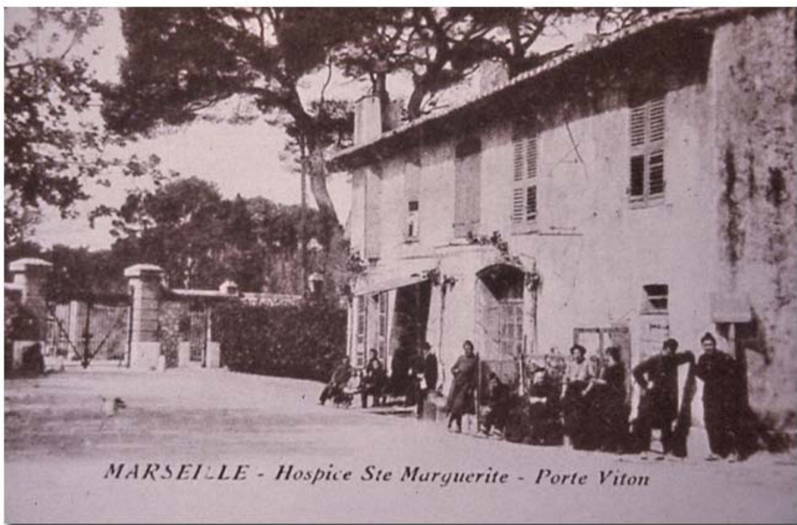
Photo 2 - Portail d'origine de la propriété Lafon. Le bâtiment de droite était également là avant l'achat par les Hospices
